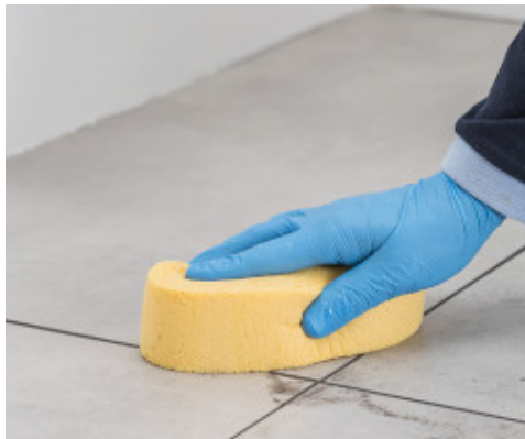
Met een spons verwijderen van resten Flexcolor 4 LVT van het tegeloppervlak
