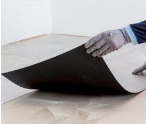
Verlijmen van LVT tegels met Ultrabond Eco 4 LVT
