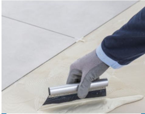
Aanbrengen van Ultrabond Eco 4 LVT en verlijmen van LVT tegels met brede voegen en voegkruisjes
