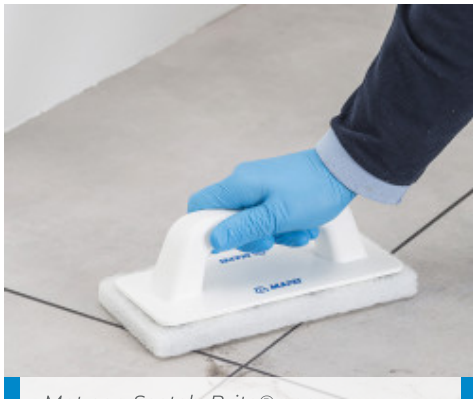
Met een Scotch-Brite® spons verwijderen van resten die na enkele uren nog zichtbaar zijn
